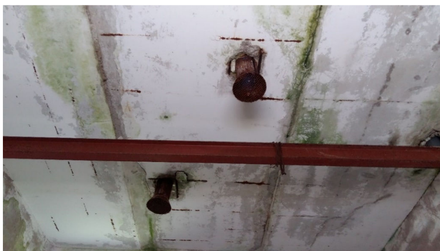
Zdj. 2 Widok stropu z płyt kanałowych w budynku przepompowni
