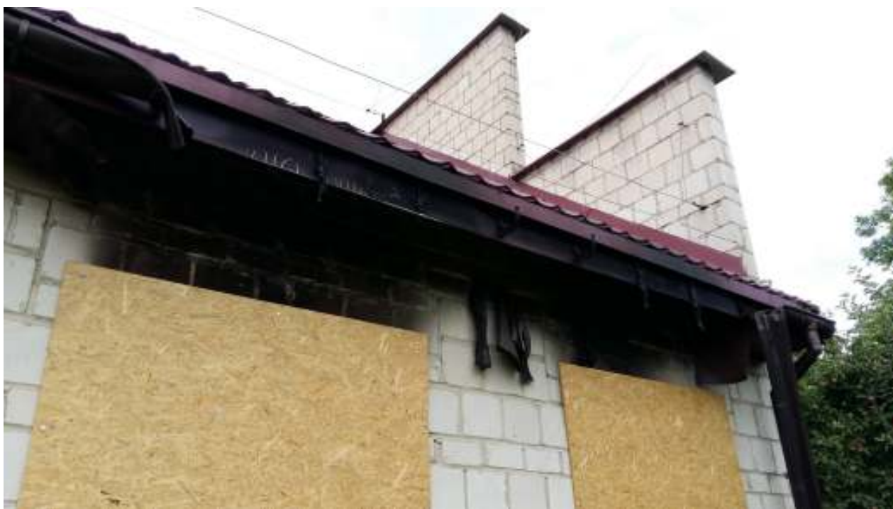
Zdj.4 Widok uszkodzeń powstałych po pożarze budynku
